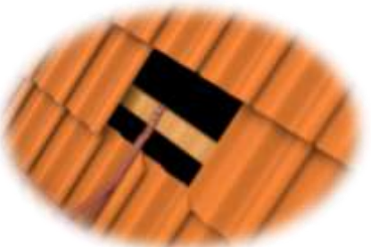
Montage-bräda 22x120 spikas eller skruvas fackmässigt i takstolarna samt i strö-läkt/undertak
